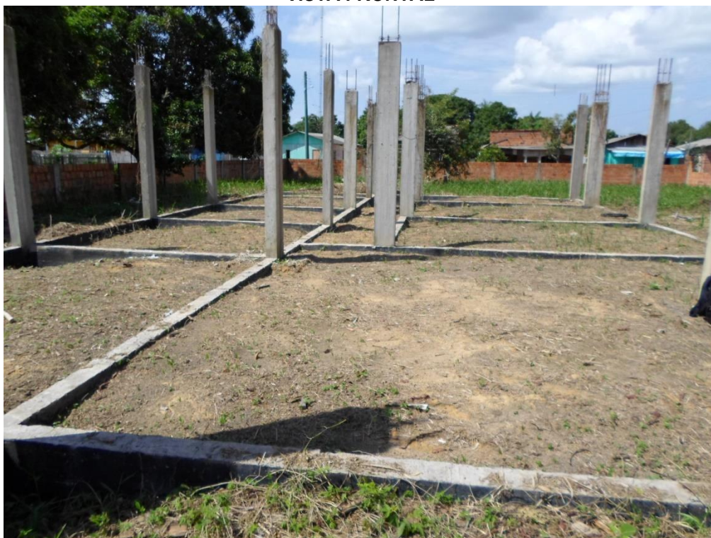
DETALHES DOS BALDRAMES E PILARES EXECUTADOS
